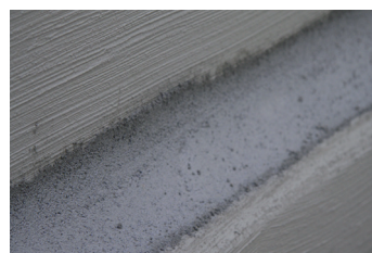
2. Hullkil med KÖSTER Sperrmörtel
