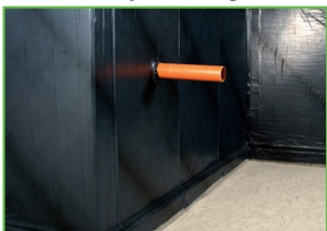
Tetningen er installert.
