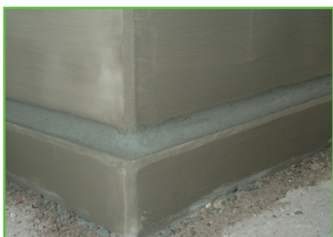
Forbehandling av underlaget
